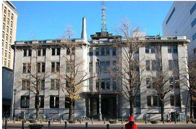
三井物産横浜ビル：明治43年竣工(1910年)築112年 改修済み
